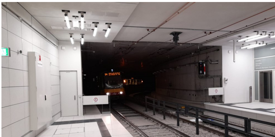
Niveaugleiches Gleisdreieck an der Karlsruher U-Haltestelle Marktplatz (Pyramide) im Stil einer U-Straßenbahn im Stadtbahntunnel der „Kombilösung“ (AG).
