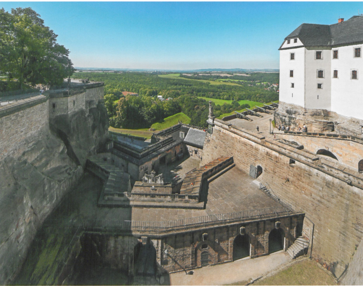
Abb. 10 Die Befestigungen am Eingangsbereich der Festung Königstein (von innen nach außen): Grabenschere/Hornwerk, Torravelin und Niedere Werke (Pfeilschanze)
