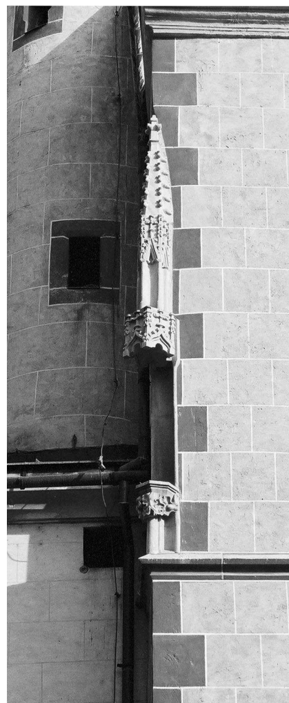
Abb. 6. Neusohl, Fronleichnamskapelle an der Pfarrkirche; Figurennische an der südwestlichen Ecke
