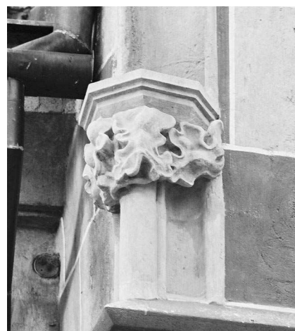
Abb. 7. Neusohl, Fronleichnamskapelle an der Pfarrkirche; Konsole der Figurennische an der südwestlichen Ecke
