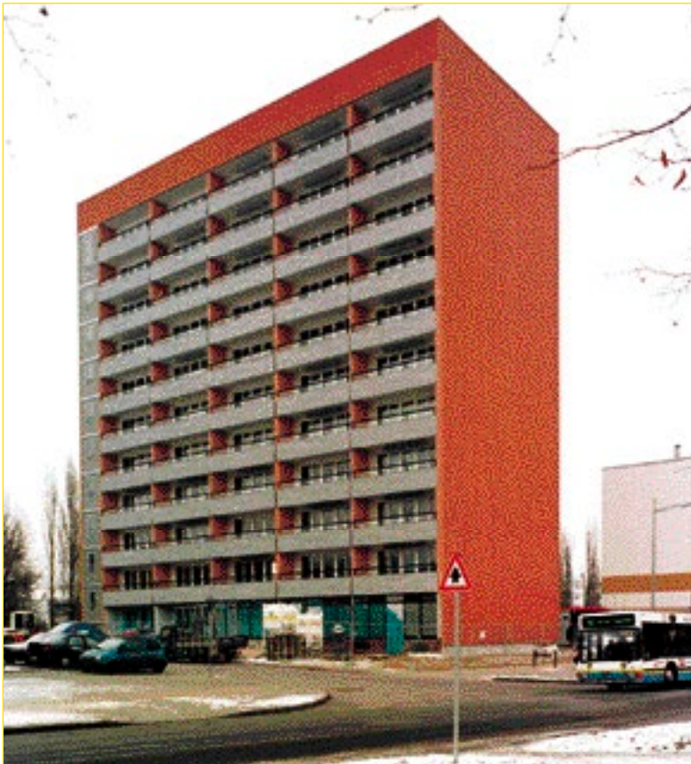
Wieder ansehnlich: Das Hochhaus in der Lessingstraße
