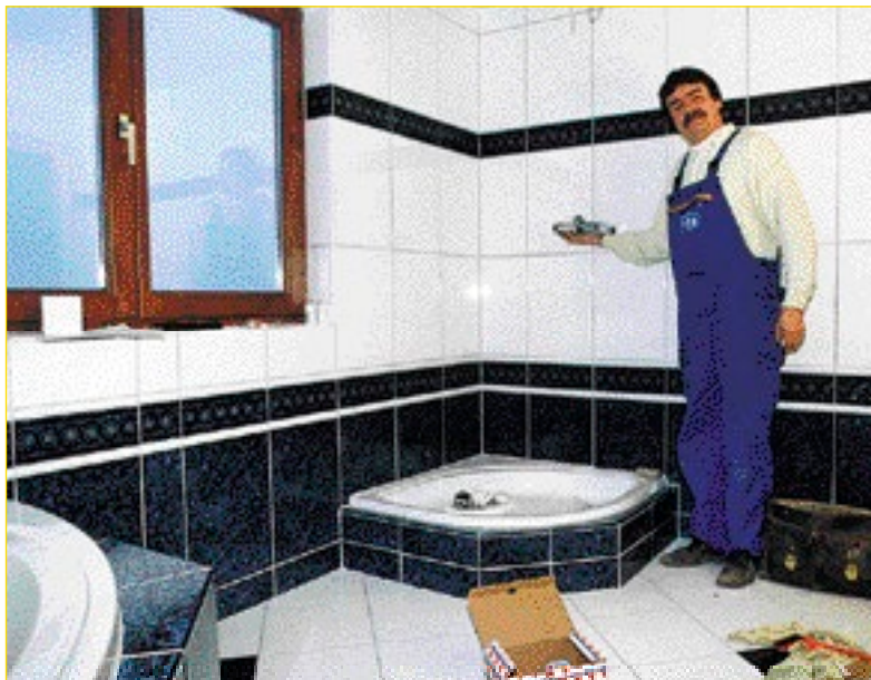
KPB-Monteur installiert moderne Bäder nach individuellen Wünschen Foto: maxpress
