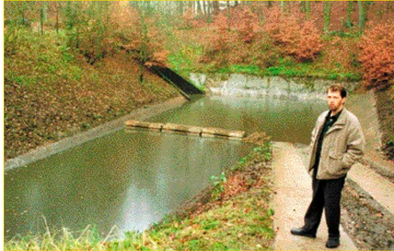
Jörn Reinhardt am Regenrückhaltebecken in der Ziolkowskistraße
