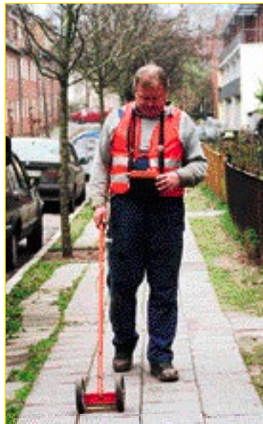
Gasspürwart Wilfried Schomann von den Stadtwerken Schwerin prüft mit dem hochempfindlichen Gasspürgerät die Gasleitungen in der Landeshauptstadt. Das Gerät erfaßt Gaskonzentrationen im Promillebereich
