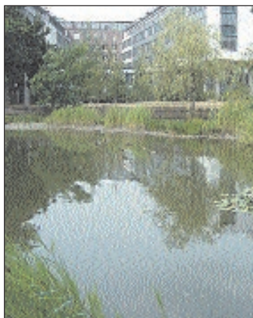
Jede Menge High-Tech verborgen unter der Wasseroberfläche: Retentionsbecken am Bleicher Ufer Foto: Reinhardt/SAE
