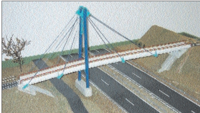
Modell der mit dem Ingenieurpreis ausgezeichneten glasfaserverstärkten Kunststoffbrücke. Im Oktober wird sie in Neumühle über die B 106 gebaut Foto: Becker
