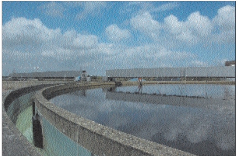
In der Biokläranlage in Schwerin-Süd wachsen täglich Milliarden von Mikroorganismen heran. Im Bioreaktor der Anlage helfen sie so, das Abwasser zu reinigen Foto: max
