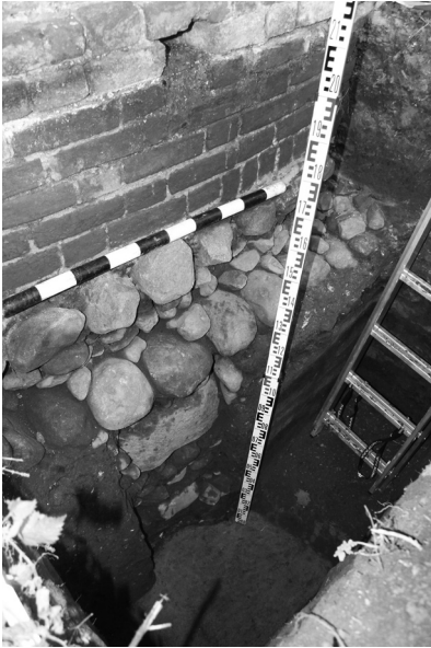
Рис. 7. Церковь Архистратига Михаила. Фундамент апсиды (шурф 8). Вид с юго-востока
