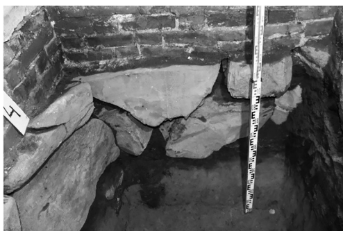
Рис. 13. Георгиевская церковь. Шурф 4. Фундамент южной стены храма
