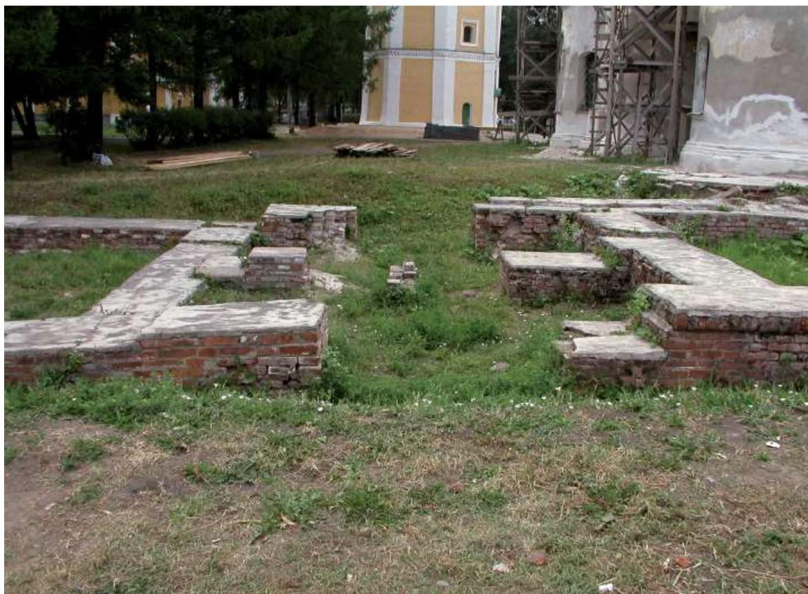
**Рис. 4. Кладки нижних частей стен воротного проезда дворца угличских удельных князей после консервации начала 1990-х гг. Вид со стороны внутреннего двора дворца. Фото 2002 г.**
