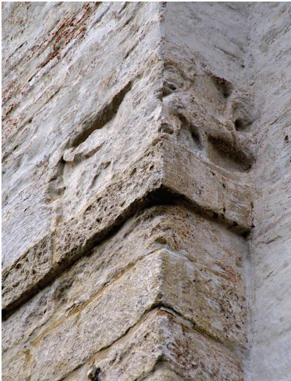
Рис. 3. Рельефы львов на фасадной пилястре юго-восточного угла
