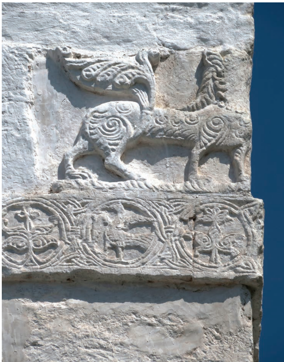
Рис. 2. Рельефы львов на фасадной пилястре юго-западного угла
