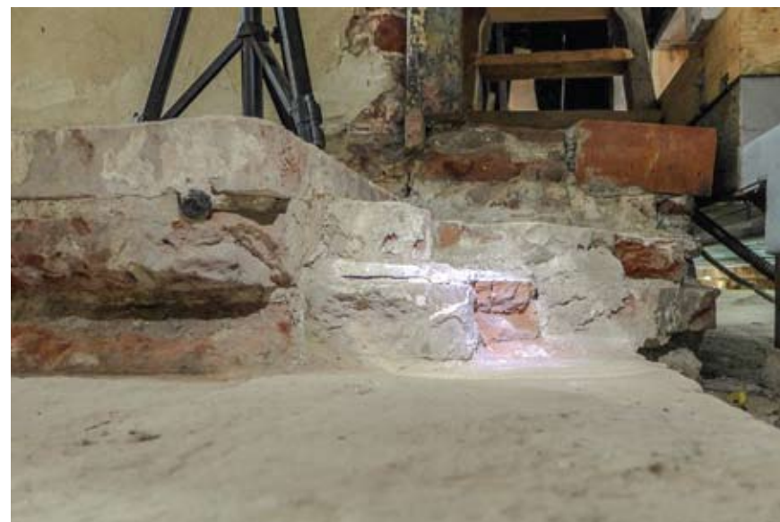
Ил. 4. Фресковый гвоздь и следы левкаса на откосах дверного проёма алтарной преграды и элементах северного портала. Фото 2018 г.
