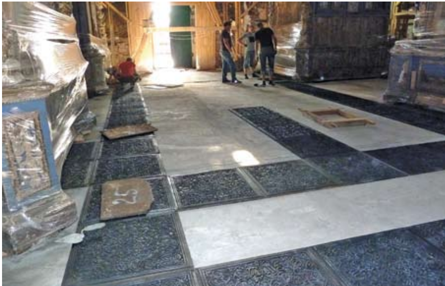
Ил. 13. Укладка чугунных плит пола на технический горизонт. Вид с юго-востока
