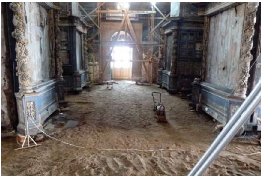
Ил. 6. Утрамбовка подсытки после снятия плит пола. Центральный неф собора, вид с востока
