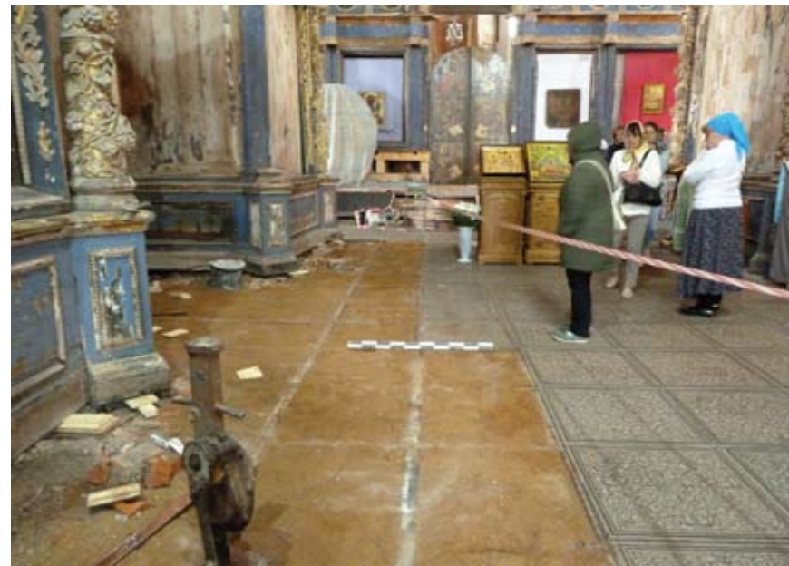
Ил. 2. Начало работ. Демонтаж плит пола в центральной части собора. Вид с запада
