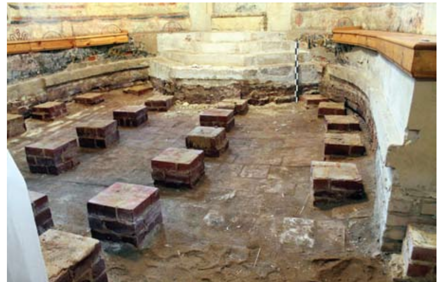
Ил. 14. Алтарь. Столбики-опоры под лаги деревянного пола. Вид с юго-запада
