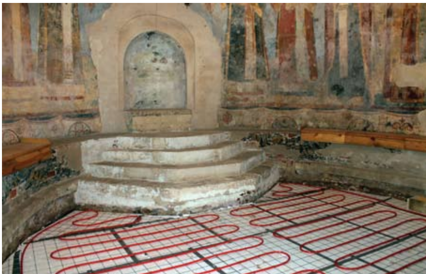
Ил. 15. Алтарь. Монтаж технического горизонта отопительной системы. Вид с северо-запада
