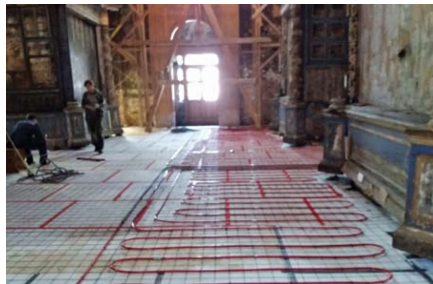
Ил. 12. Монтаж технического горизонта системы «тёплый пол». Центральный неф собора. Вид с востока
