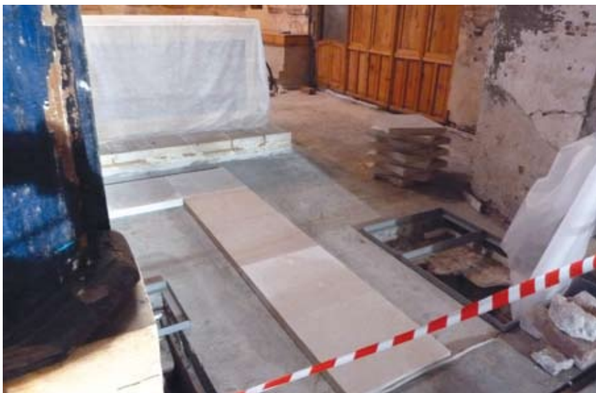
Ил. 16. Алтарь. Укладка белокаменных плит пола
