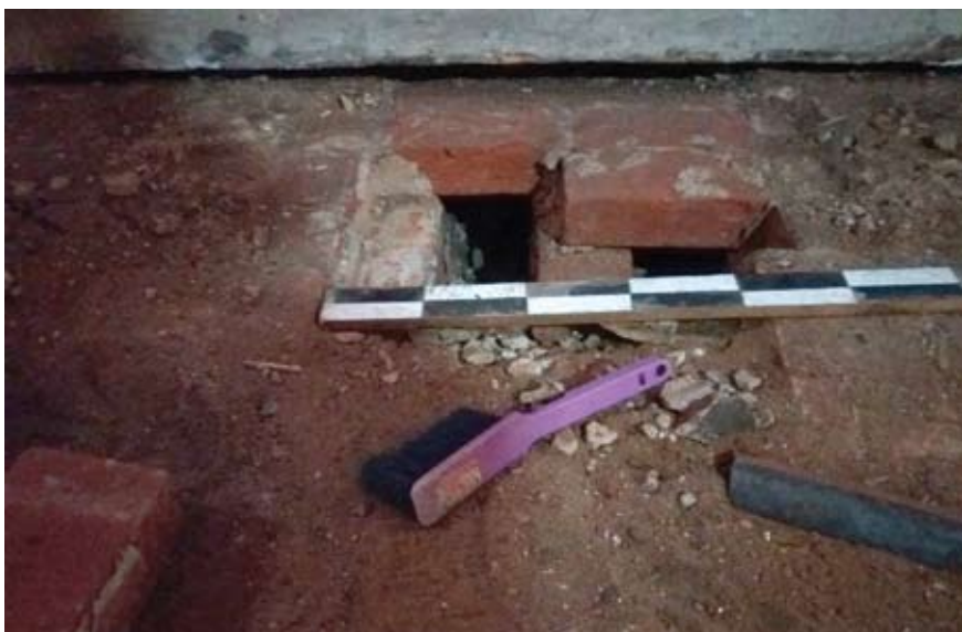
Ил. 4. Остатки калориферного хода у западной стены северо-восточного столба четверика. Вид с запада
