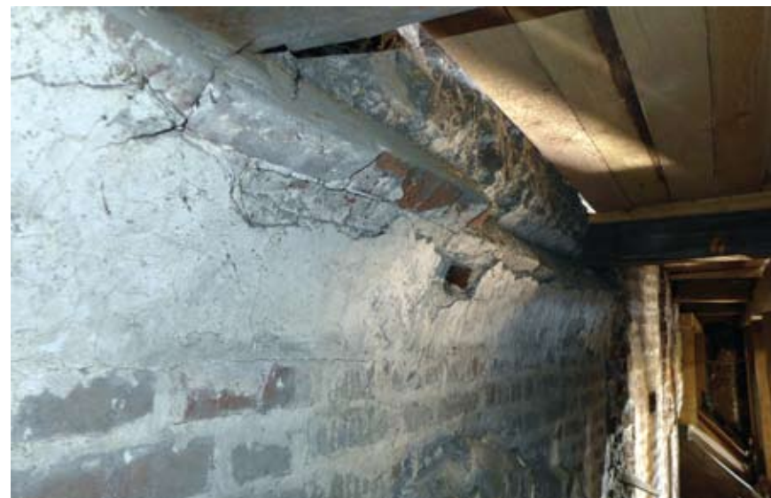
Ил. 8. Пята коробового свода над проёмом царских врат в центральной алтарной преграде. Обломанная металлическая связь. Ниже — шельга вставной арки. Фото 2018 г.
