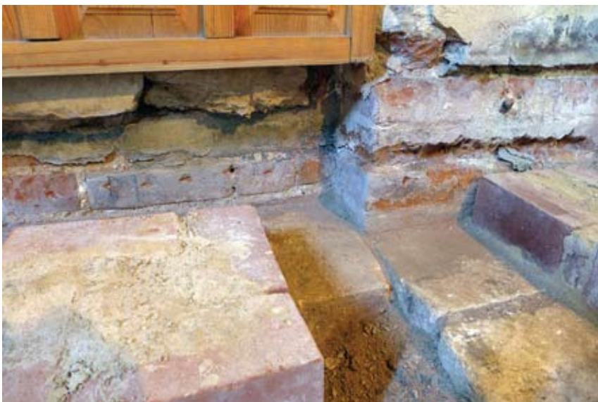
Ил. 14. Место примыкания стены, разделяющей южную и центральную апсиды, к восточной грани юго-восточного столба. Вид с севера. Фото 2018 г.
