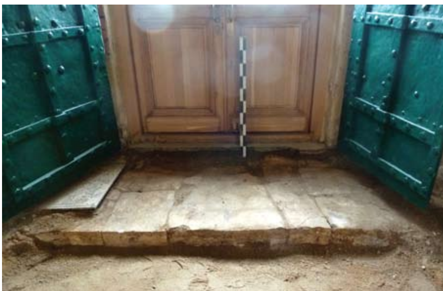
Ил. 7. Ступень белокаменной лестницы у западного портала
