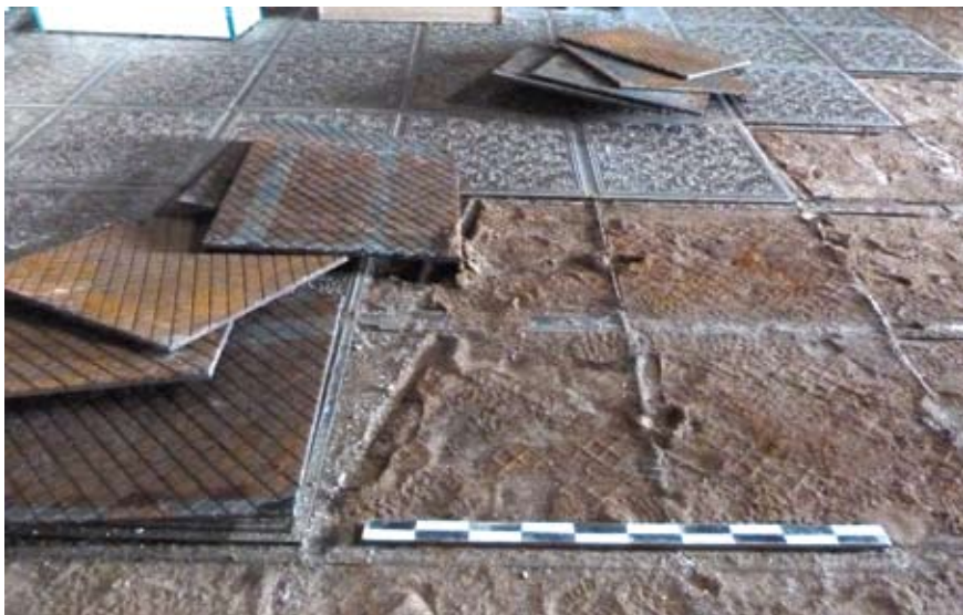
Ил. 3. Песчаная засыпка подпольного пространства и балки-опоры под плиты пола. Вид с запада
