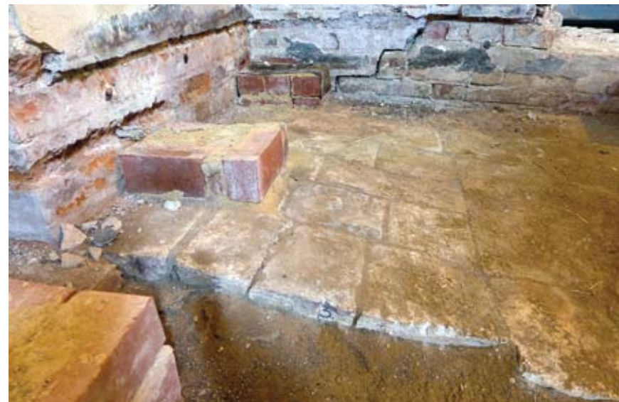
Ил. 5. Белокаменный пол начала XVI в. в примыкании к внутренней плоскости алтарной преграды в центральной арке. Нижние ряды южного участка алтарной преграды начала XVI в. Фото 2018 г.
