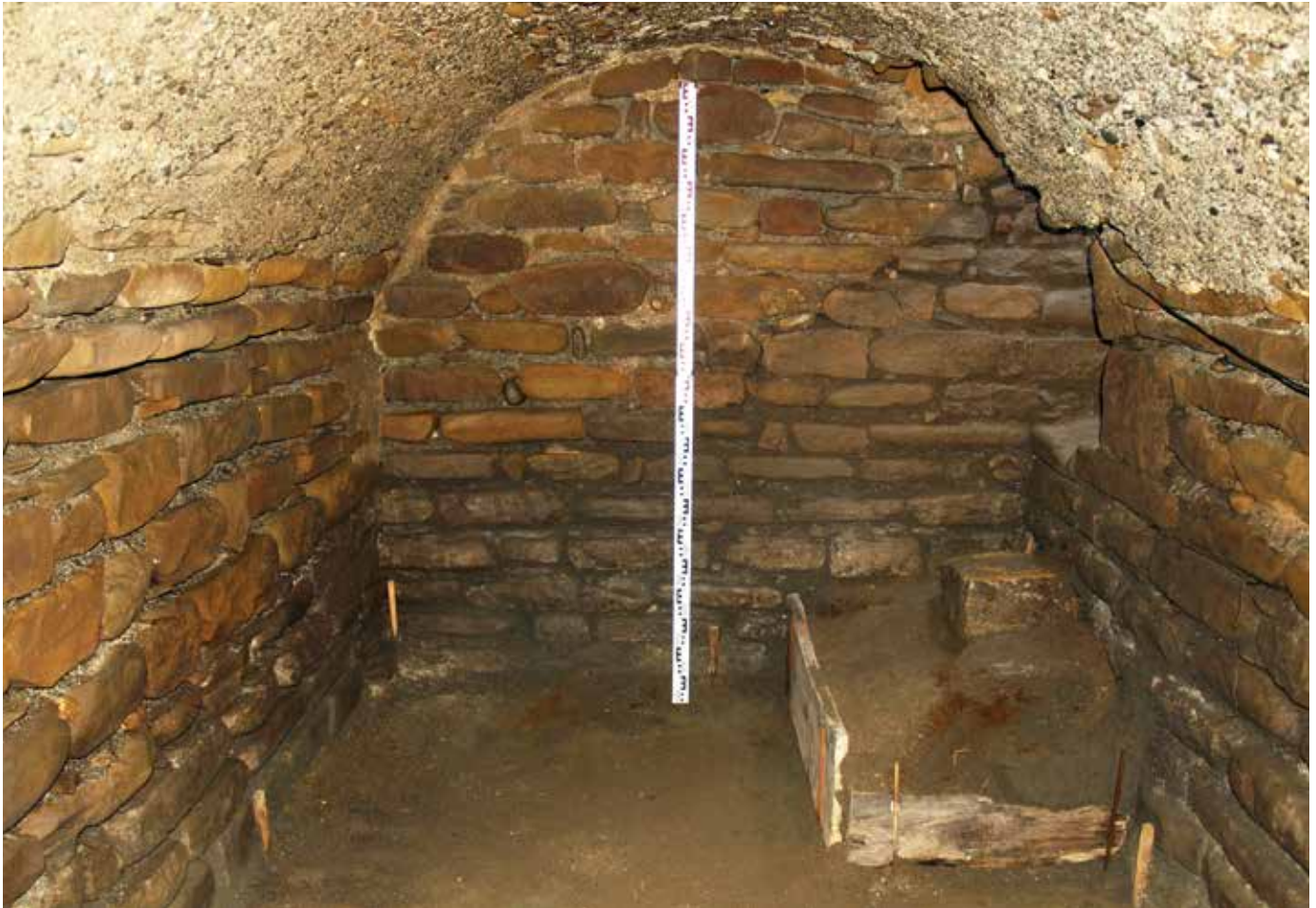
Рис. 3. Склеп под нартексом. Вид с севера.
