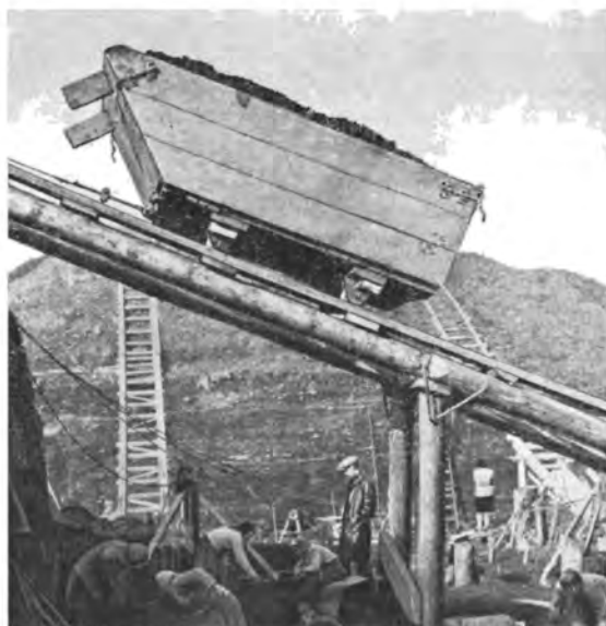
Рис. 22. Скиповый подъемник на Неревском раскопе
