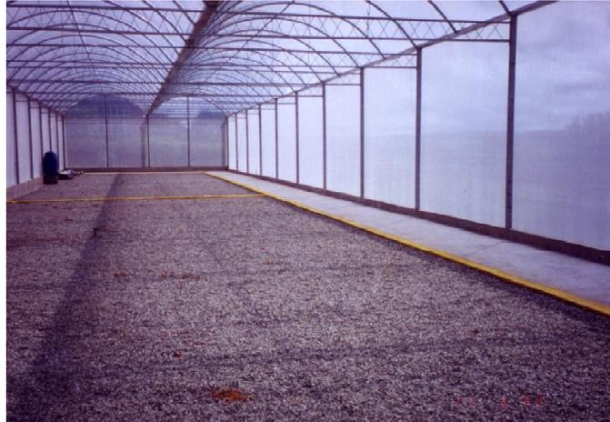
**Figura 6.** Vista interna do borbulheiro da Embrapa Clima Temperado, antes da colocação das plantas, podendo ser observado o revestimento com pedra britada e os corredores de circulação concretados.
