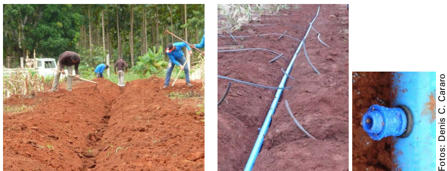
Figura 25. Sistema de irrigação em fase de instalação.
