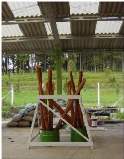
**Figura 2.** Tratamento preservativo pelo método prático da substituição de seiva.
