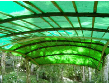
Figura 1. Galhos de pinheiro usados em construção.
