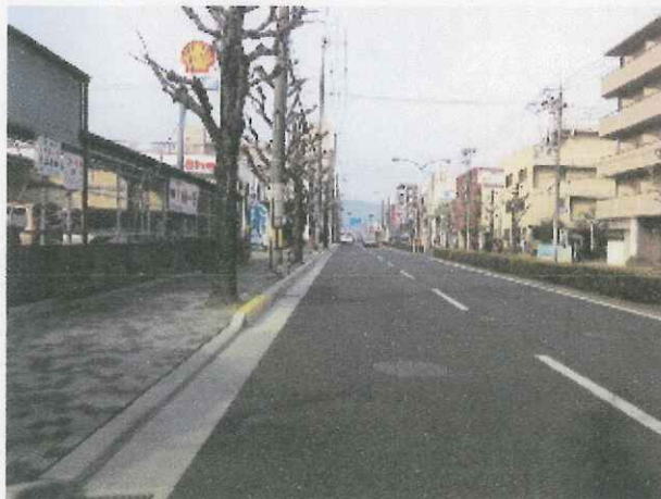
歩道も狭くないが植栽もあるので、歩道上には設置せず車道左端にレーンを引くべき
