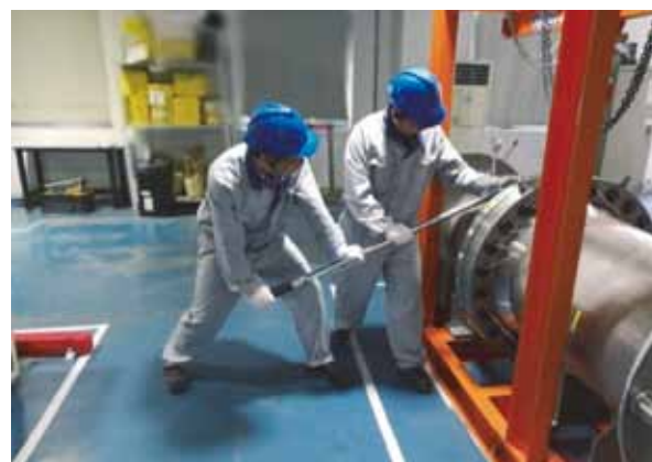
Figure 2 締付け作業の写真
