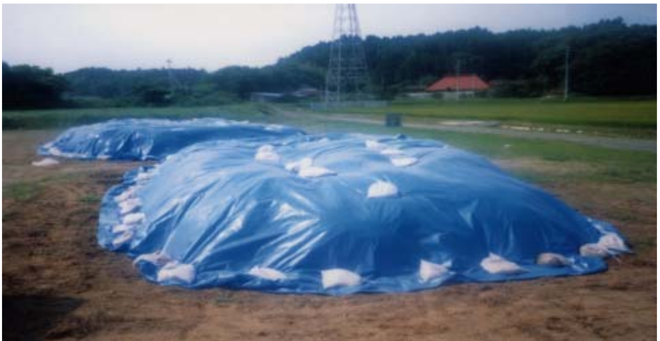
シート養生状況
