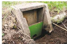
田んぼダム(排水柵に調整板を設置)
