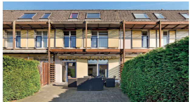
De energiewoningen in Schiedam waren destijds een toonbeeld van duurzaam bouwen en ze zijn zelfs naar huidige maatstaven zuinig.
