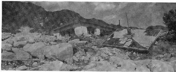
90 山津波に激滅した大野陸軍病院（左端の山より決壊した）
