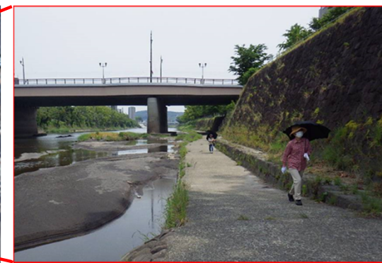
下流河川の遊歩道の状況
