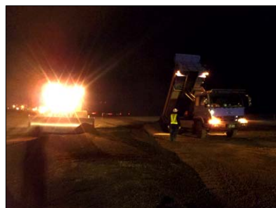
写真－4 覆土工夜間施工状況
