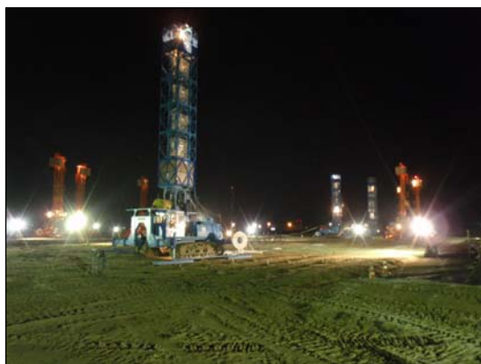
写真－3 地盤改良工夜間施工状況
