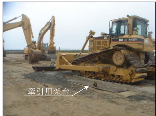
写真-5 牽引用架台
