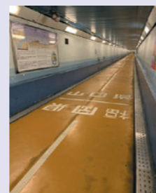
関門トンネル人道
