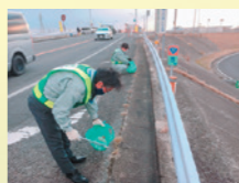
【森永建設株式会社】「肥前・美ロード活動」と称して気持ちのいい道に!
