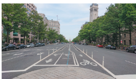
車線中央部に自転車走行区間を整備
