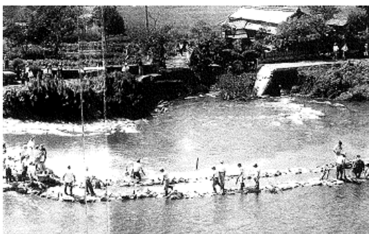
当時の堤防決壊写真 福岡県土木課
