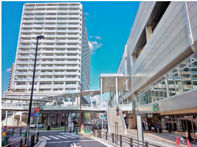
写真－3 京急蒲田駅西口付近の様子
