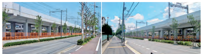
高架構造物全景
