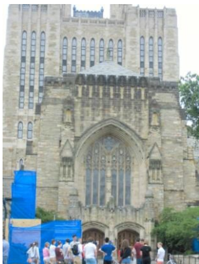
写真1 改装中のスターリング図書館
