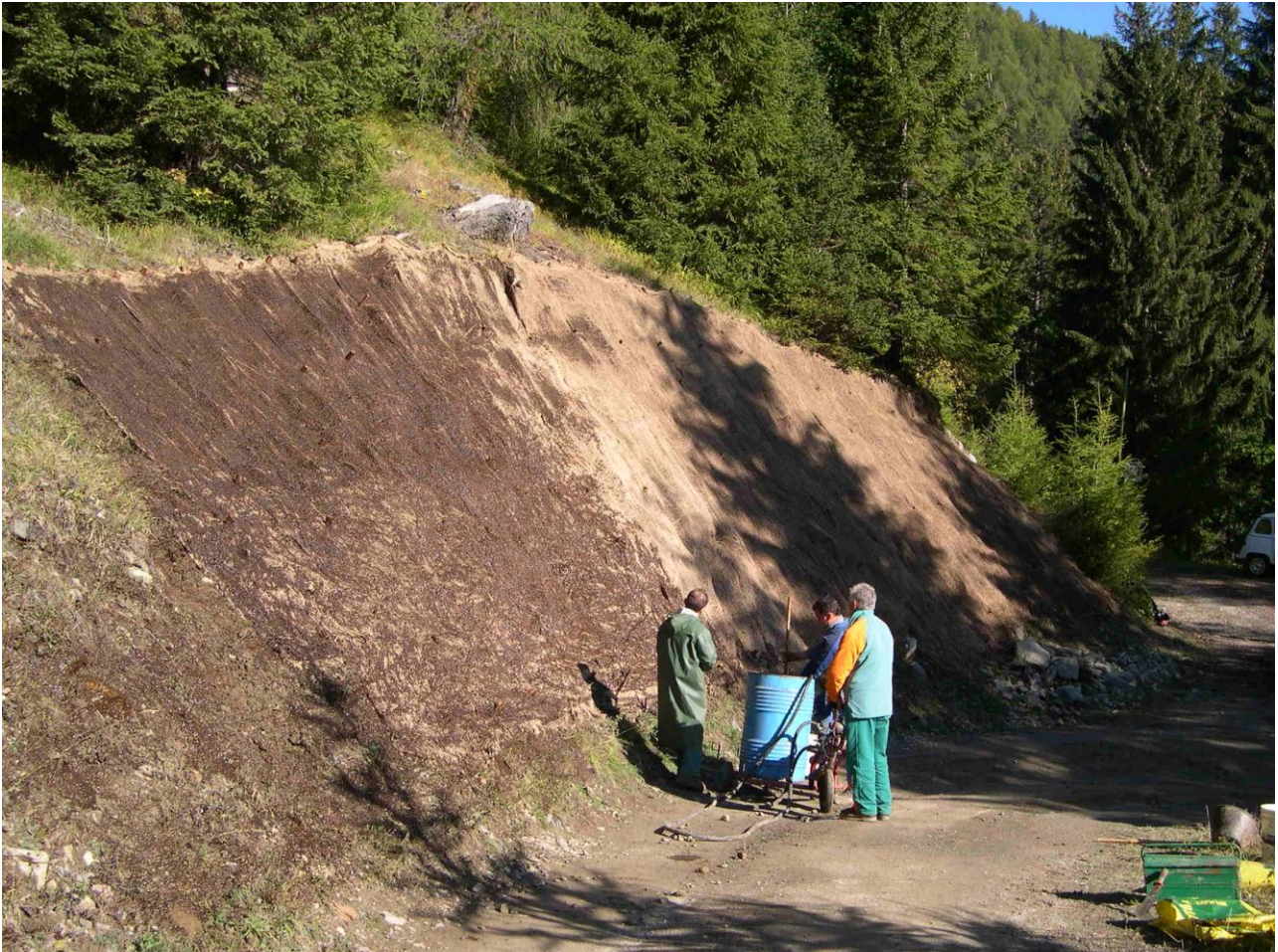
Fig. 9 – Consolidamento di scarpata mediante tecnica di idrosemina.
