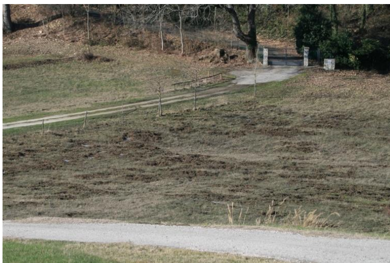
Fig. 66 - Risultato dell'attività di "rooting" in zona Ca' Busignano, Chiesanuova.
