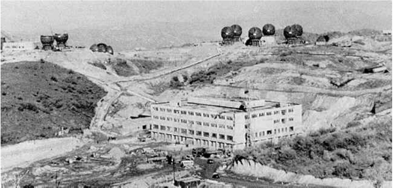
Комплекс "Окно" в процессе строительства в 80-е гг. (Фото газеты "Правда" с сайта FAS.)
