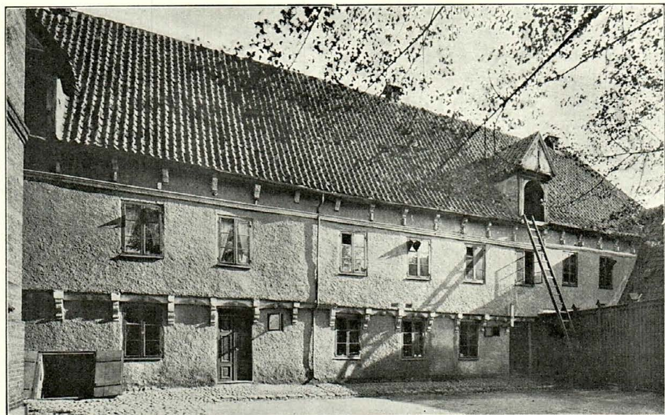
Bryggarnas lagshus i kv. Gråbröder, kärnan i Barnhuskomplexet. Axel Sjöberg foto 1899.
