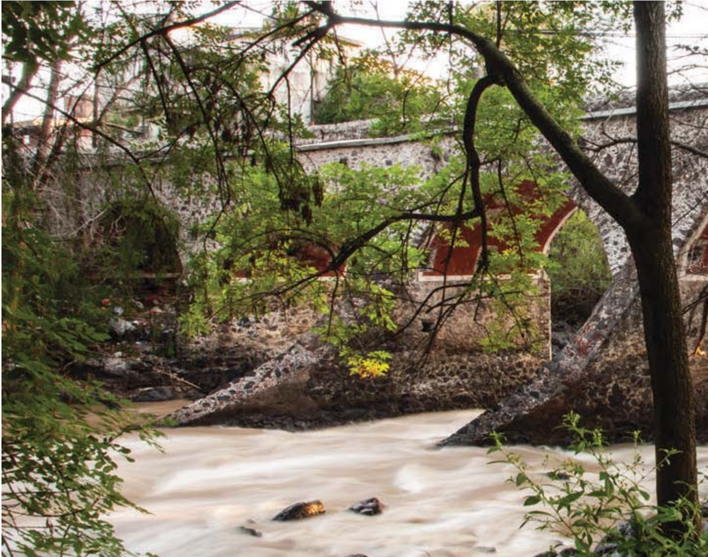
Batanes Bridge, Guanajuato.
