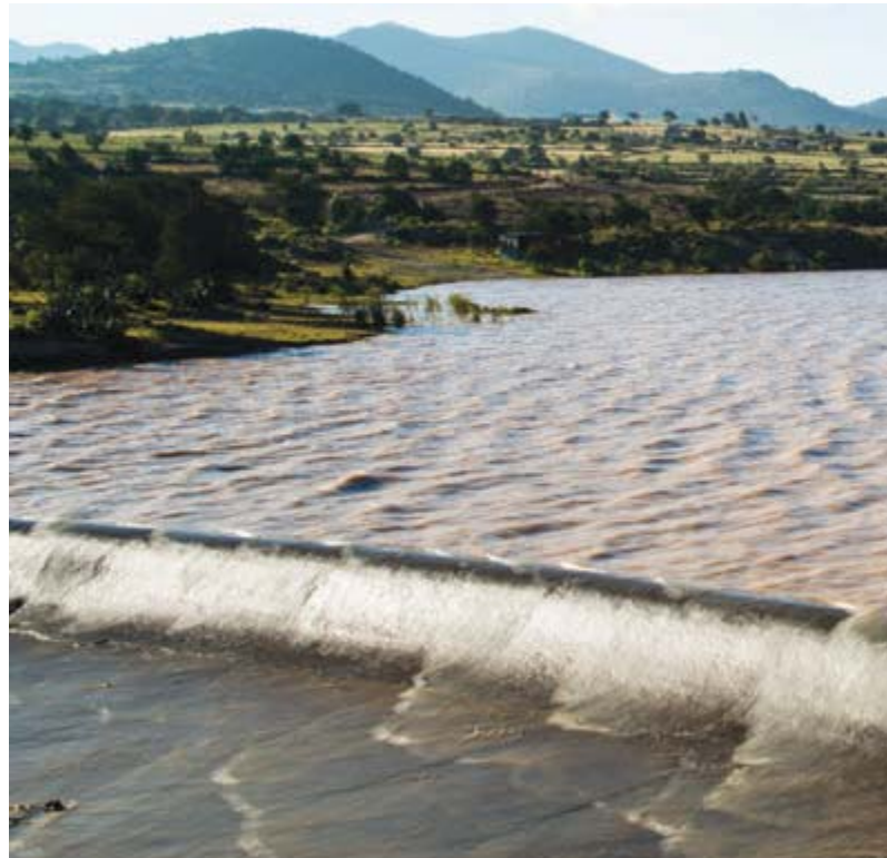
Lázaro Cárdenas Dam, Tlaxcala.
