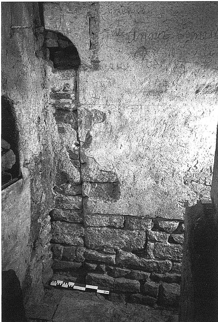
FIG. 13.- Griselles, crypte, mur sud, détail de la porte bouchée retrouvée
