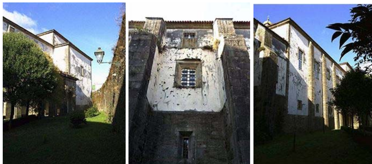
Intervención en los revocos, en las cubiertas y en el patio de acceso a la iglesia del convento de Santa Clara
