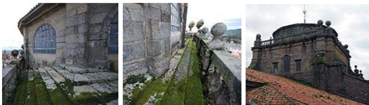
Limpieza del cimborrio de la iglesia de San Martín Pinario
