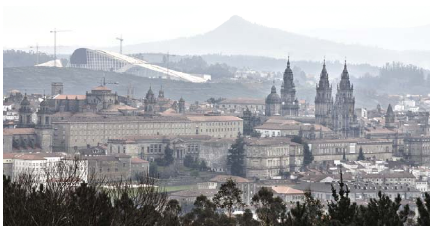
Imagen de la Ciudad de la Cultura durante su construcción.
