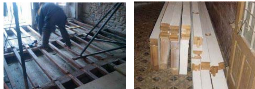
Trabajos de rehabilitación en una vivienda de la Ciudad Histórica
