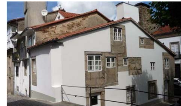
Vivienda rehabilitada mediante un programa del Consorcio
