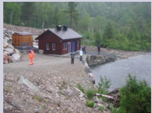
Ved småkraftutbygging legger NVE vekt på at arealene både ved kraftstasjon og andre steder hvor det er gjort inngrep blir satt i stand. Foto: Jon Arne Eie.
