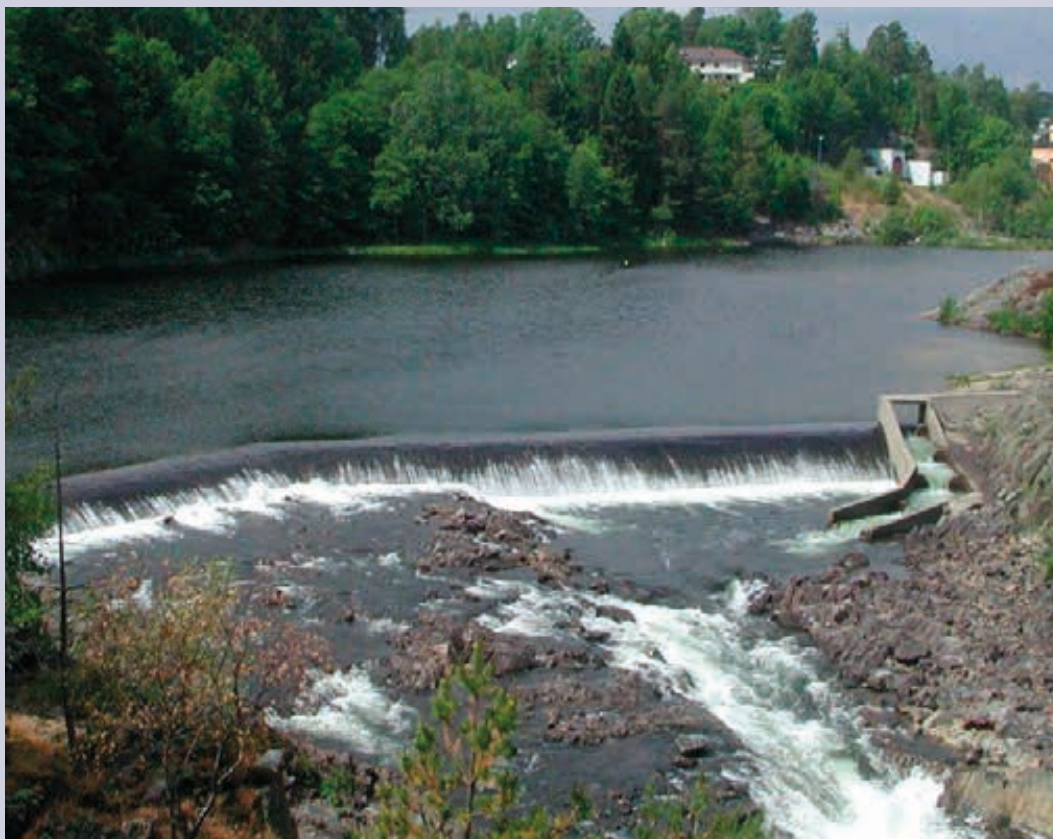
Det er bygd mange forskjellige terskler i regulerte vassdrag. Formålet har ofte vært flersidig; opprettholde et vannspeil av estetiske hensyn og samtidig opprettholde biologisk produksjon. Her fra Arendalsvassdraget hvor det også ble bygd laksetrapp. Foto Jon Arne Eie.
