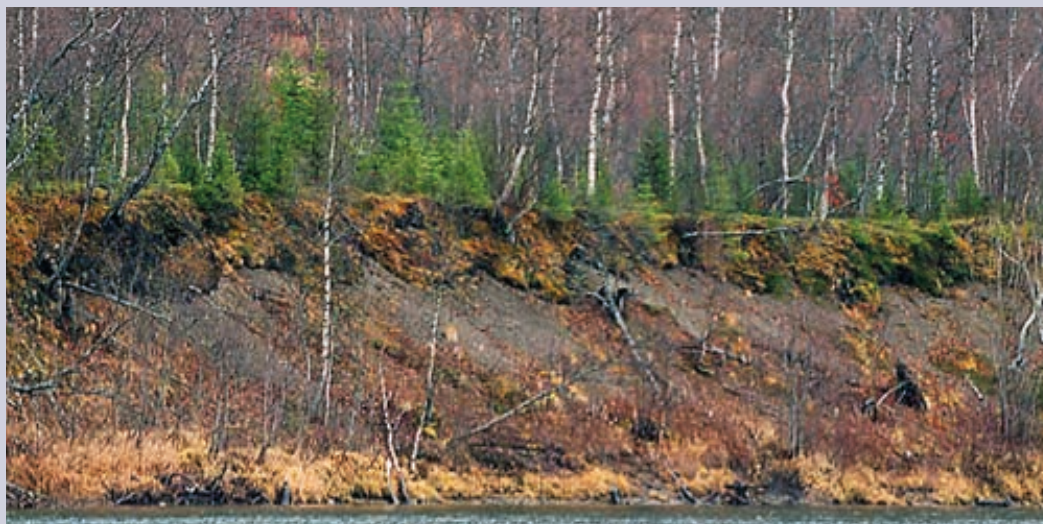
Raske vannføringsendringer kan føre til erosjon. Foto: Jim Bogen.
