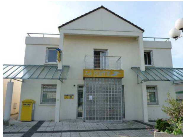
Photographie 34 : La Poste avec logement au dessus
