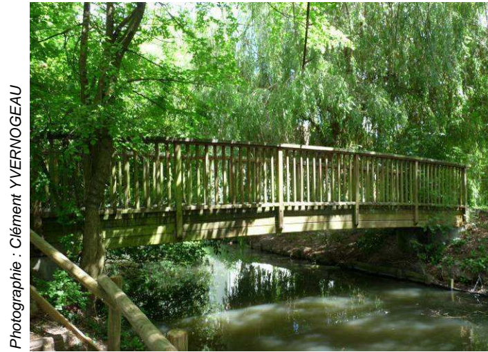
Photographie 7 : Passerelle sur la Bionne à côté du pont routier
