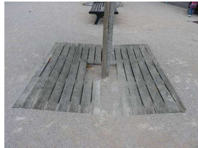
Photographie 48 : Planches au sol
