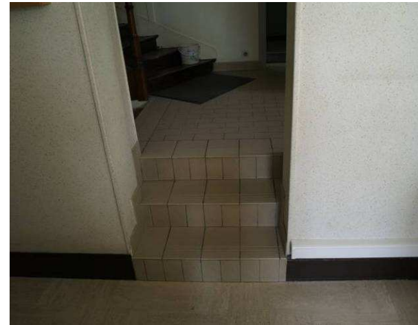
Photographie 86 : Marches intérieures
