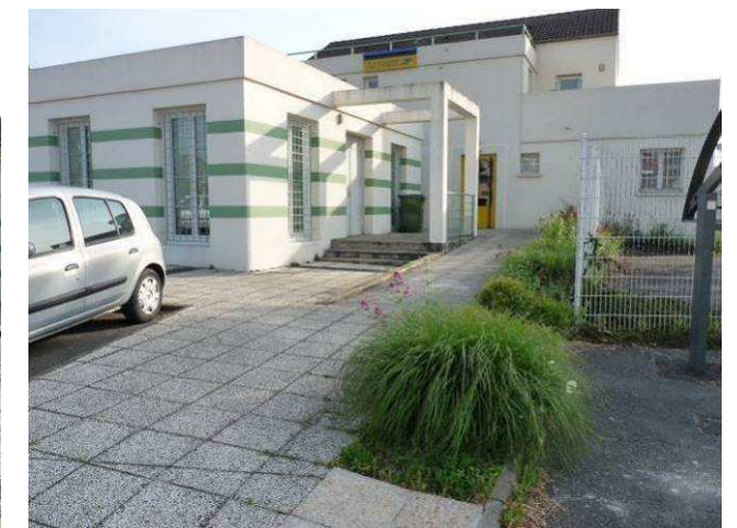
Photographie 28 : Rampe d'accès
