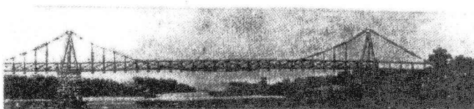
写真一 フィンレイが1801年最初に架設した近代吊橋ジェイコブス・クリーク (Jacobs Creek) 橋 2)
