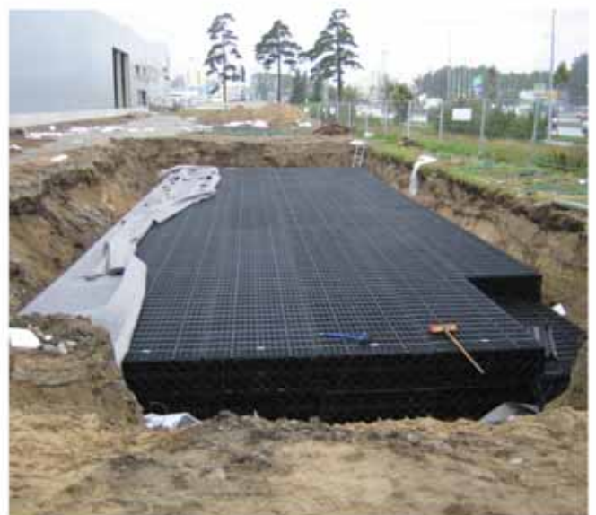
Foto 2. Tammsaare tee äärde ehitatud Tondi Rautakesko kaupluse hoone katuse- ja parkimisplatsivee juhitakse HeitkerBloc -moodulitest koostatud mahutisse
