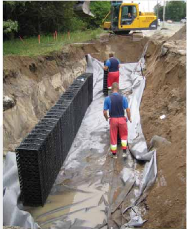
Foto 3. HeitkerBloc -moodulite paigaldamine Merivälja tee rekonstrueerimisel
