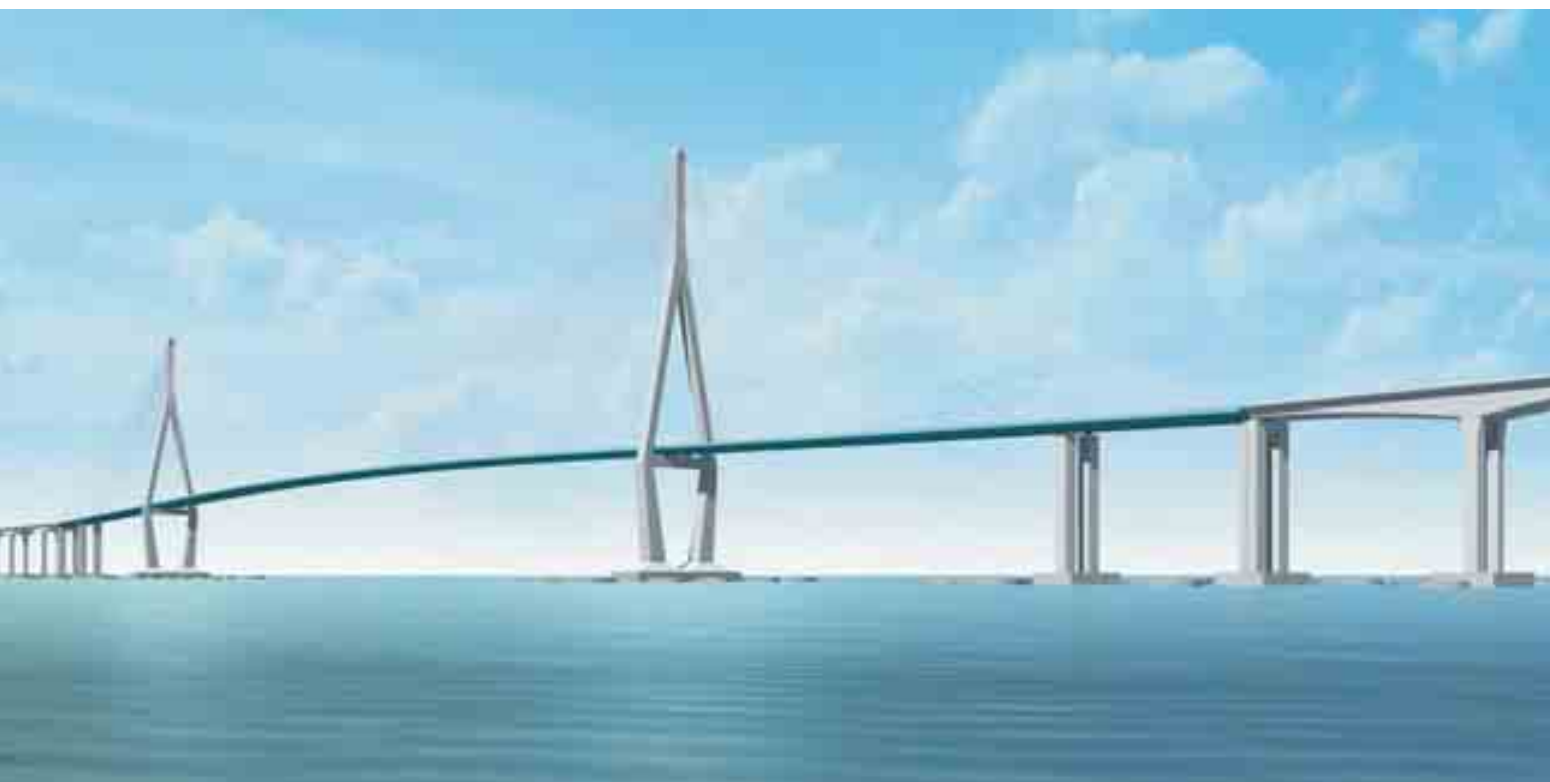
Silla Incheon Grand Bridge üldvaade
