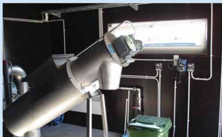
Automaatne kruvivõre. Laitse reoveepuhasti tehnohoone.
