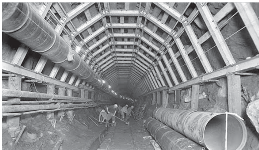
Joonis 1. Delaware'i tunnel
