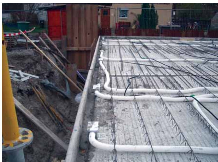
InFloor-süsteem paigaldamise ajal
