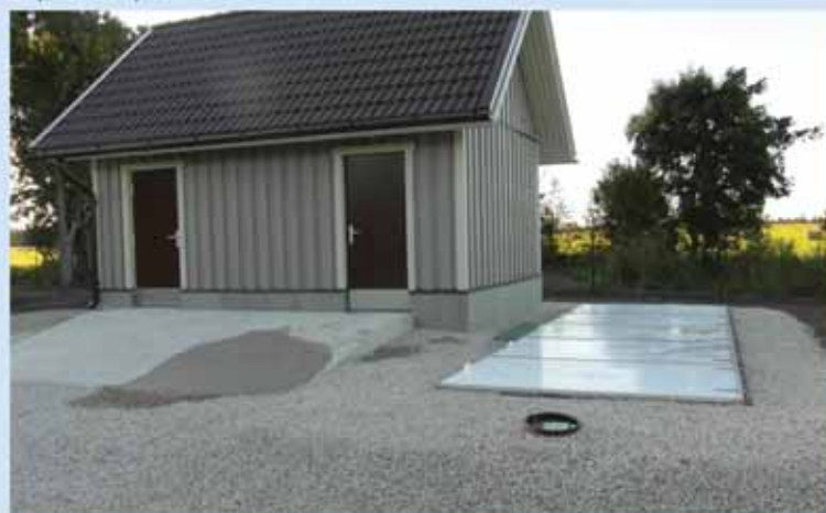
Laitse küla reoveepuhasti. Fotol teenindushoone ja konteinerpuhasti. Laitse küla reoveepuhasti on ehitatud 2012. aastal Keskkonnainvesteeringute Keskuse kaasrahastamisel. Töö tellija: Kernu Vallavalitsus. Puhasti jõudlus: 45m 3 /d (300 IE)
