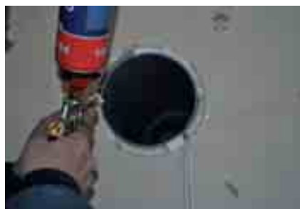
Õhukanalite paigaldamine välisseina
