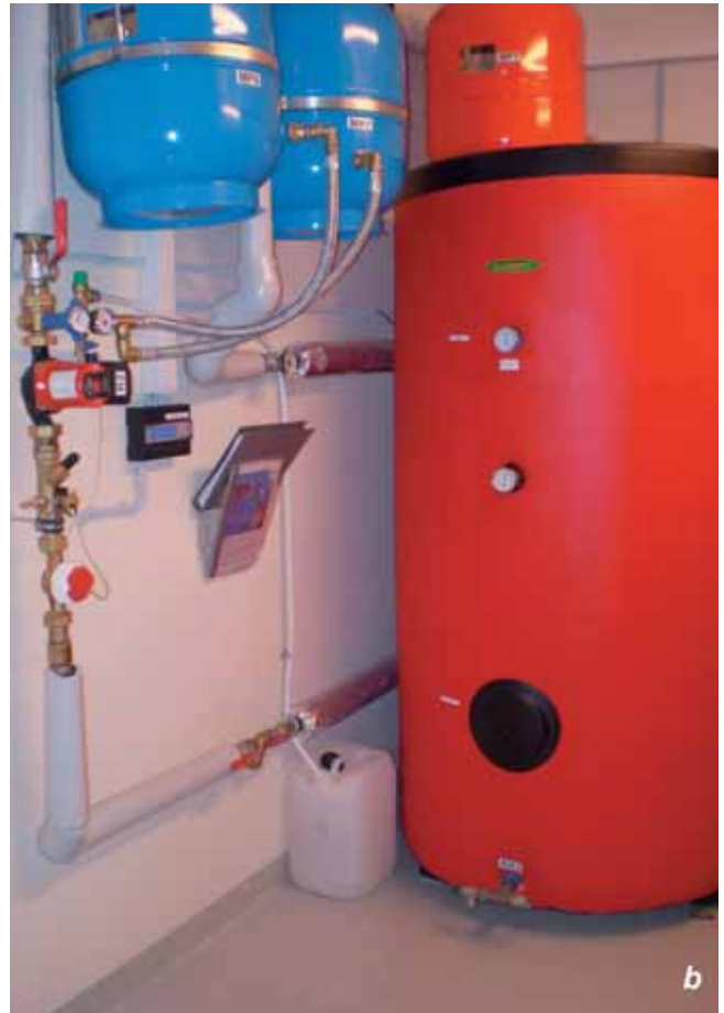
Joonis 7. Katlaruum: a – 300 kW pelletikatel, b – seinäl päikesekütte juhtautomaatika ja paisupaagid. Päikeseküttesalvesti maht on 1000 liitrit
