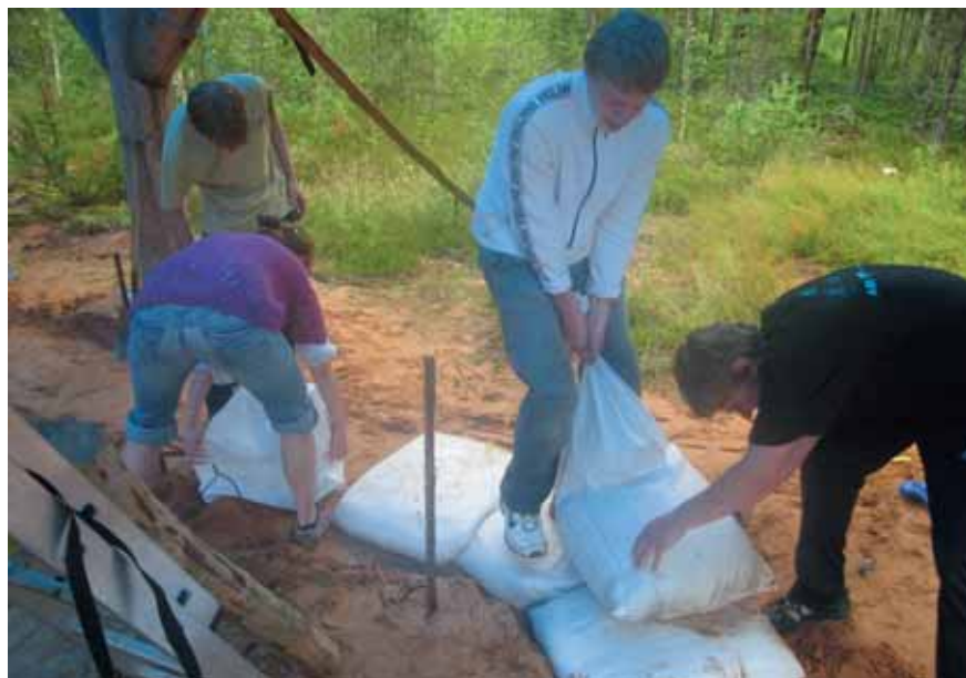
Liivakottidest vundamenti ladumine
