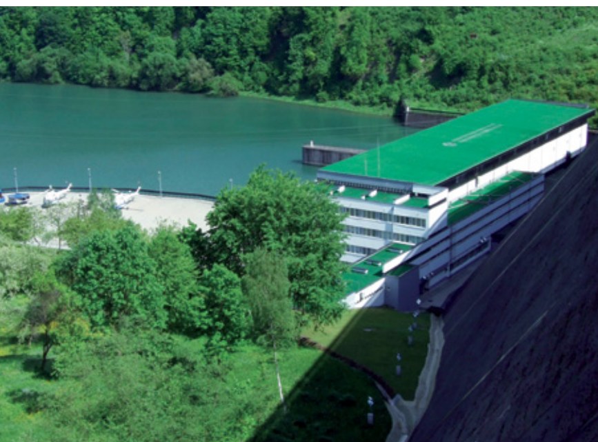
Elektrownia wodna w Rzeszowie (fot. fotoforum.gazeta.pl)
