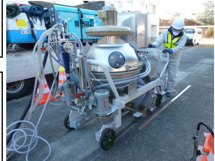
団地内舗装面の除染作業
