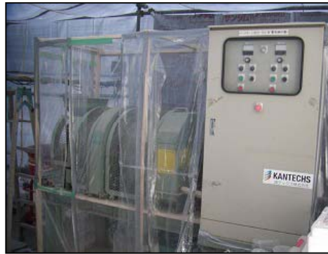
②磨砕洗浄機ハリケーンによる洗浄
