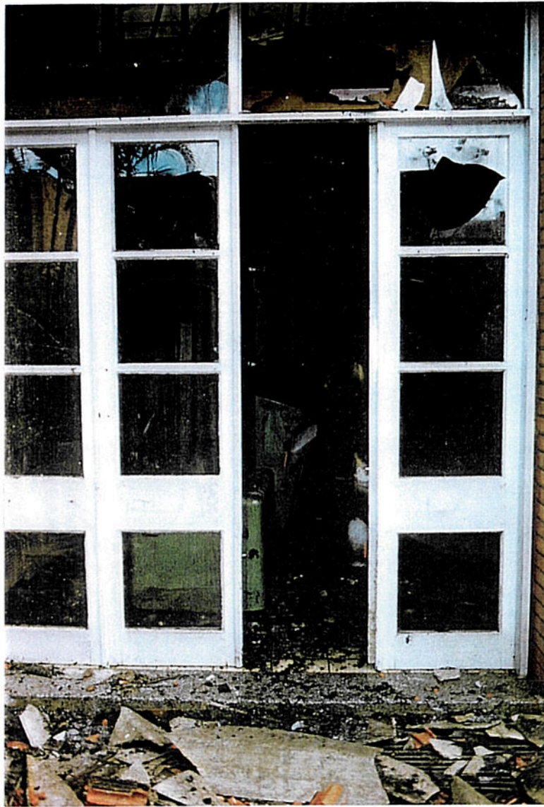
VISTA DA ENTRADA DO PRÉDIO
