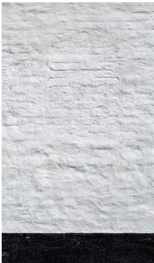
Fig. 7. Blændet, oprindeligt vindue østligt i det gamle skibs sydside (s. 3986). Foto Arnold Mikkelsen 2016. – Bricked-up original window in the east of the south side of the old nave.
