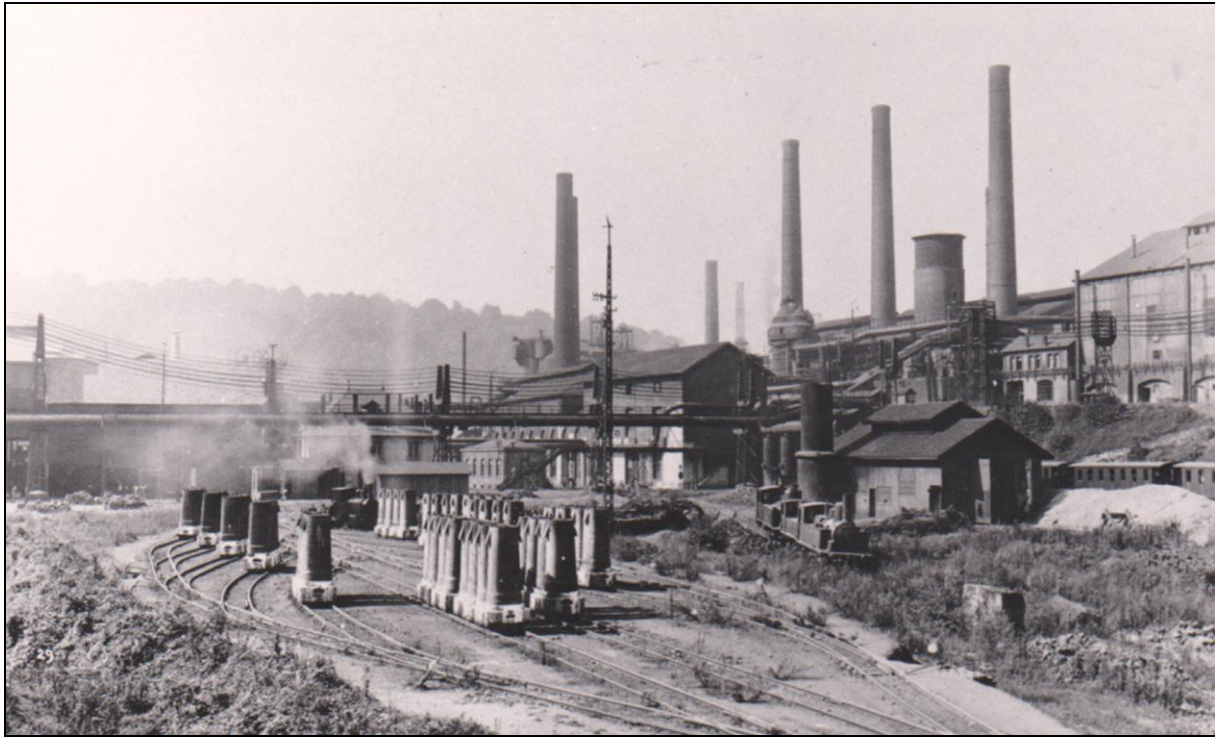
Vue de la gare à lingotières des Forges de Jœuf en 1923. À l'arrière-plan, les bâtiments de l'aciérie Thomas et, sur la droite, la halle des moteurs à gaz.
