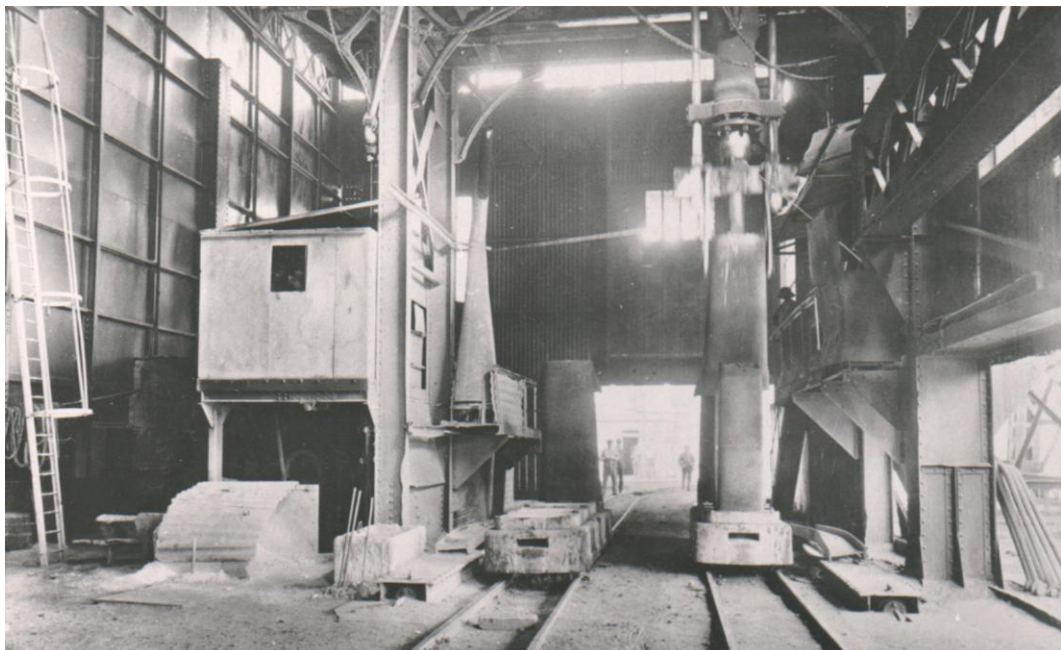
Acierie Thomas des Forges de Jœuf en 1923 : démouleur hydraulique des lingotières.
