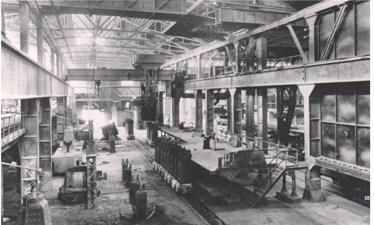
Acierie Thomas des Forges de Jœuf en 1923 : en haut, vue des installations de chargement de la chaux et des rideaux contre les projections ; ci-dessus, la halle de coulée, avec au centre les lingotières dans lesquelles on transvase l'acier en fusion recueilli dans les poches.
