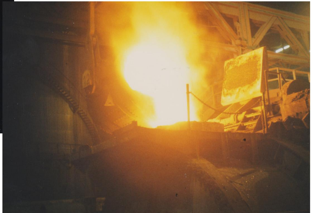
15 février 1969 : deux vues du remplissage de l'une des dernières poches de l'aciérie de Jœuf.
