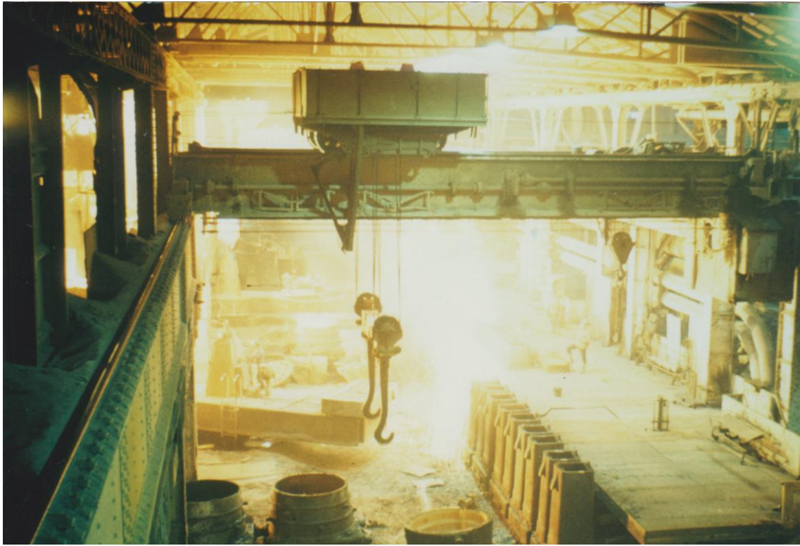
15 février 1969 : vue générale de la halle de coulée, avec le pont roulant servant à transporter les poches d'acier ; au premier plan une rangée de lingotières.
