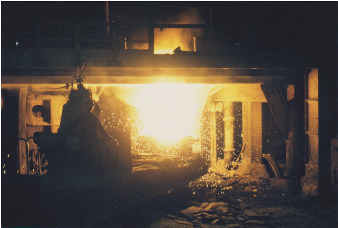
15 février 1969 : manœuvre de la poche de coulée sous le convertisseur.
