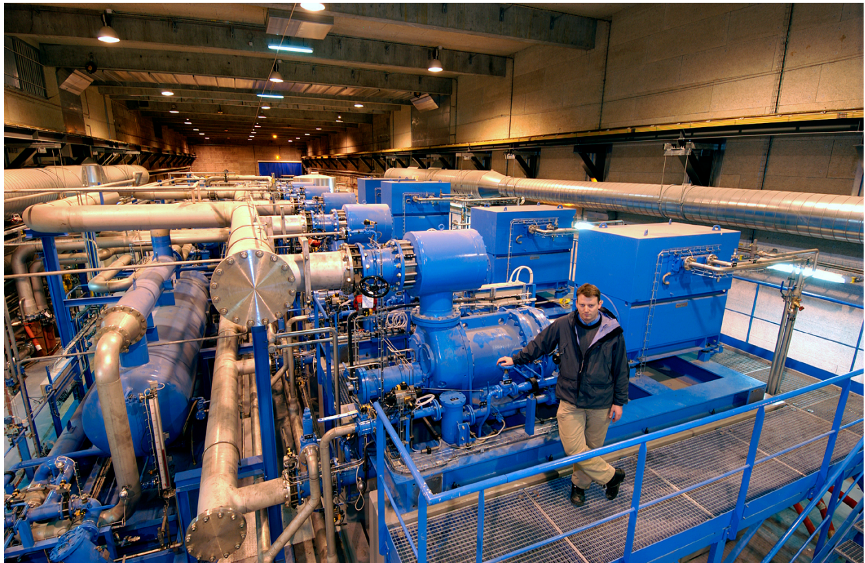
Figure 5 : Station de compression d'un grand réfrigérateur d'hélium du LHC
