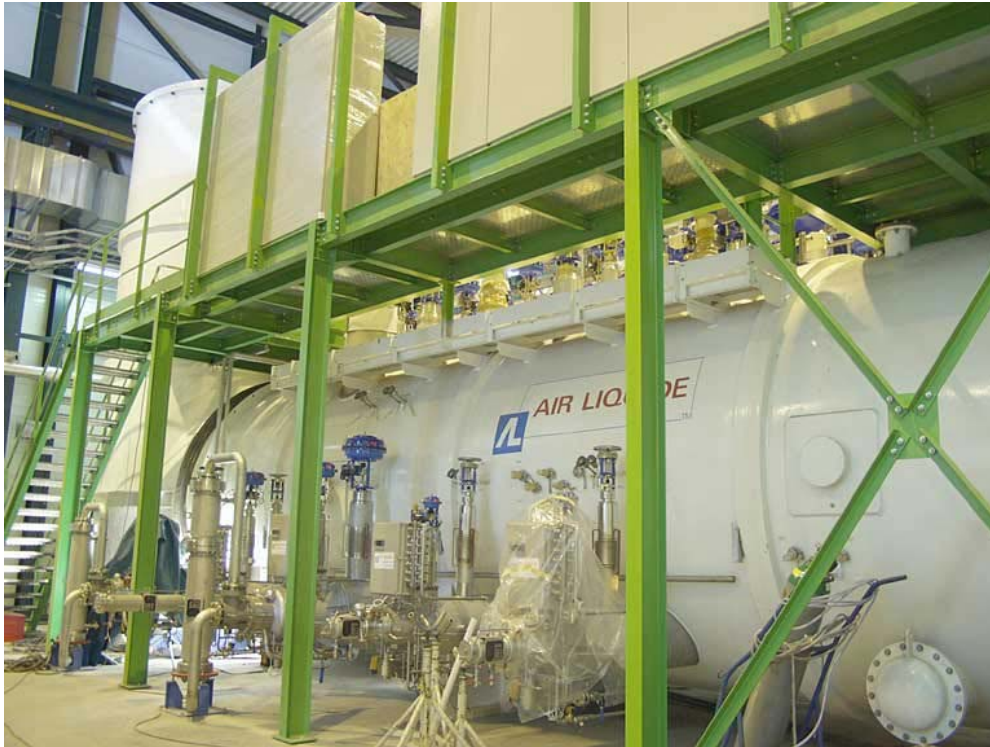
Figure 4 : Boîte froide d'un grand réfrigérateur d'hélium du LHC
