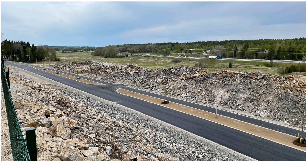
I samband med vägbyggen frigörs berg- och jordmassor. Ofta kan dessa massor återanvändas direkt på platsen. Foto: SGU.
