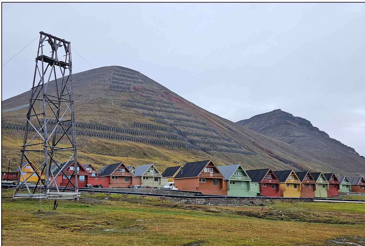
Figur 6.4 Sikringstiltak i Lia.
