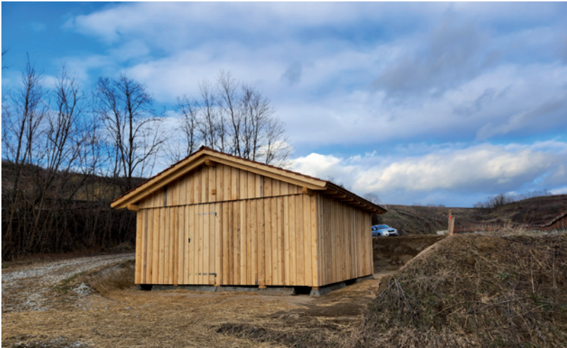
3 Kammern-Grubgraben (Österreich), Dezember 2023. Die Errichtung einer temporären Grabungsüberdachung mit aushängbaren Seitenelementen ermöglicht die detaillierte Untersuchung einer komplexen jungpaläolithischen Steinstruktur in den nächsten 10–12 Jahre | Kammern-Grubgraben (Austria), December 2023. The building of a temporary wooden construction with removable wall elements enables the investigation of a complex Upper Palaeolithic stone feature over a time period of 10–12 years (© ÖAW-ÖAI, H. Parow-Souchon)
